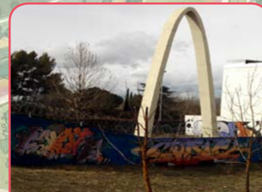
Imagen 6.5 Subestación Transformadora Ciudad Universitaria
