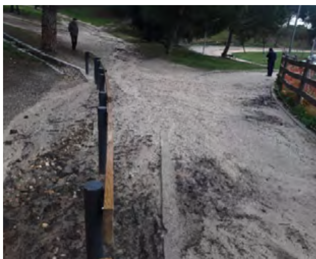
Imagen 12.3.1.1 Muestra de arrastre de material por la acción erosiva del agua de escorrentía. 2018.
