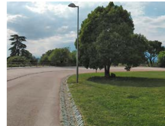
Imagen 8.3 Caceras de recogida de pluviales
