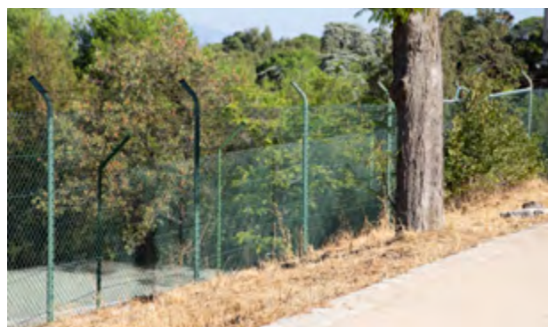
Imagen 12.2.4.2 Valla metálica de doble torsión delimitando la Dehesa con CIEMAT. 2018.
